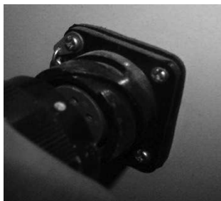
Conexão do cabo com a caixa elétrica
